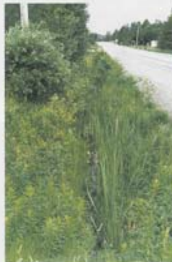
Photographie no 4 : La protection des lacs et des cours d'eau naturels commence loin en amont dans le bassin versant. Les fossés routiers constituent certainement l'un des éléments importants de la problématique, mais il en va de même de nos attitudes et de nos attentes en matière de drainage routier. Il faut à tout prix changer notre conception d'un fossé routier "propre" et s'habituer à y voir une végétation luxuriante. (Photo: RAPPEL, 97-07-07)
