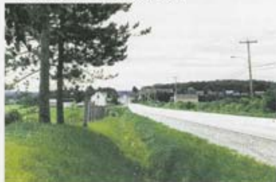
Photographie no 3 : Une route dont les fossés sont nettoyés selon la méthode du tiers inférieur s'intègre de manière plus harmonieuse dans l'environnement. Les fossés en végétation offrent une transition plus graduelle entre la route et le paysage agricole ou agro-forestier environnant. (Photo: M.T.G., 97-07-07)
